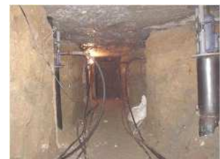
鋼管圧入工法
