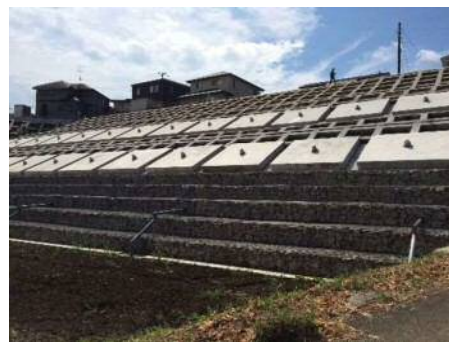
震災盛土造成地の復旧及び再度災害防止対策
