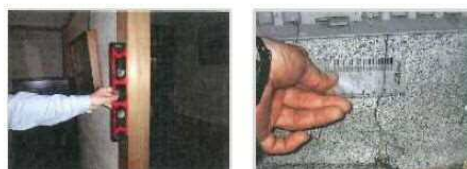
水平器による柱の傾きの計測
