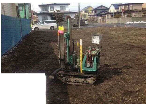
(3) 測点 ② 調査終了時 全景
