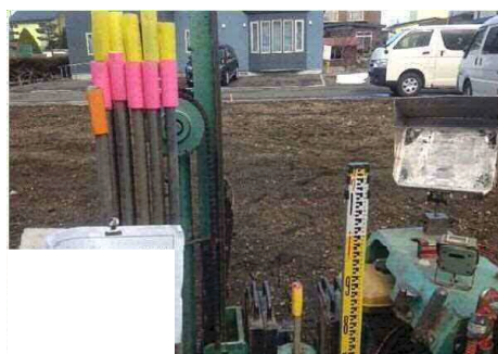
測点 ④ 調査終了時 アップ
