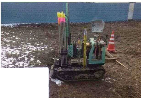
① ロッドホルダーにロッド11本残り ② 調査後のロッド残尺 0.9m(スタッフ参照) ③ 調査深度は、3.1m
