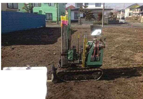
(4) 測点 ③ 調査終了時 全景
